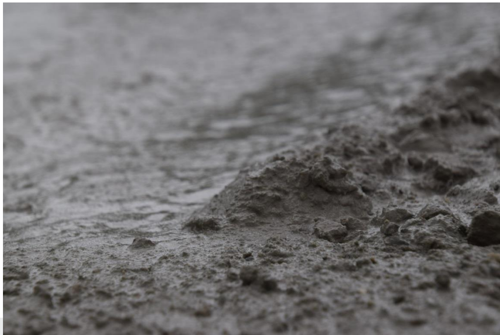
Foto: Detailopname betonmortel.
